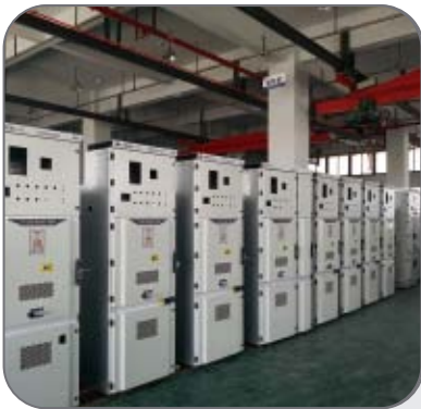
Arramcadores directos, suaves y variadores de velocidad
